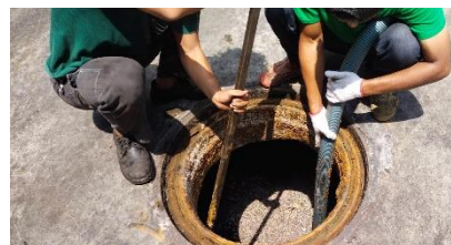
การสูบน้ำออกจากระบบบำบัดน้ำเสีย
